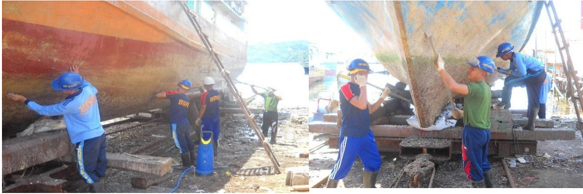
Gambar 8. Pembersihan Body Kapal
