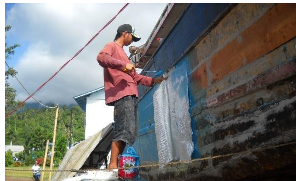
Gambar 10. Pelapisan serat fiberglass pada lambung kapal
